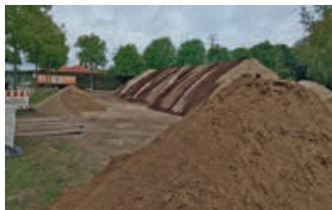
Rasentragschicht wird angemischt
