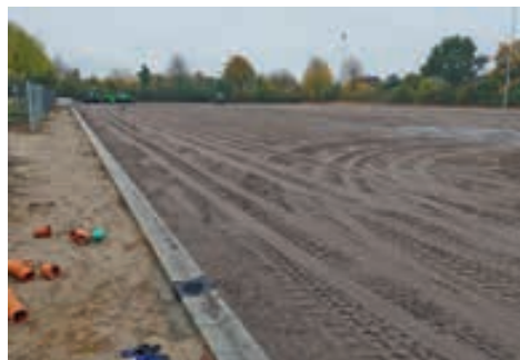
Die Rasentragschicht ist aufgebracht
