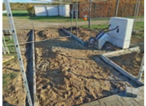
Die neue Zuwegung entsteht
