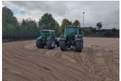
Der Untergrund wird vorbereitet
