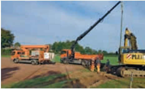
Entfernen der alten Flutlichtmasten
