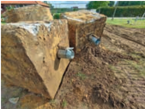
Die alten Fundamente...vor...
