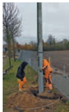
Ein Flutlichtmast wird gestellt
