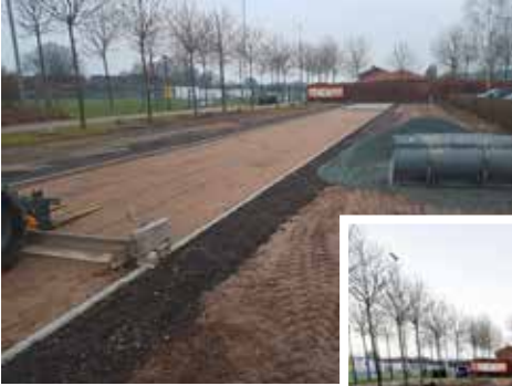
Parkplatz im Bau....
